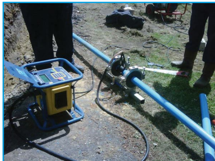
elektrofuziono varenje
