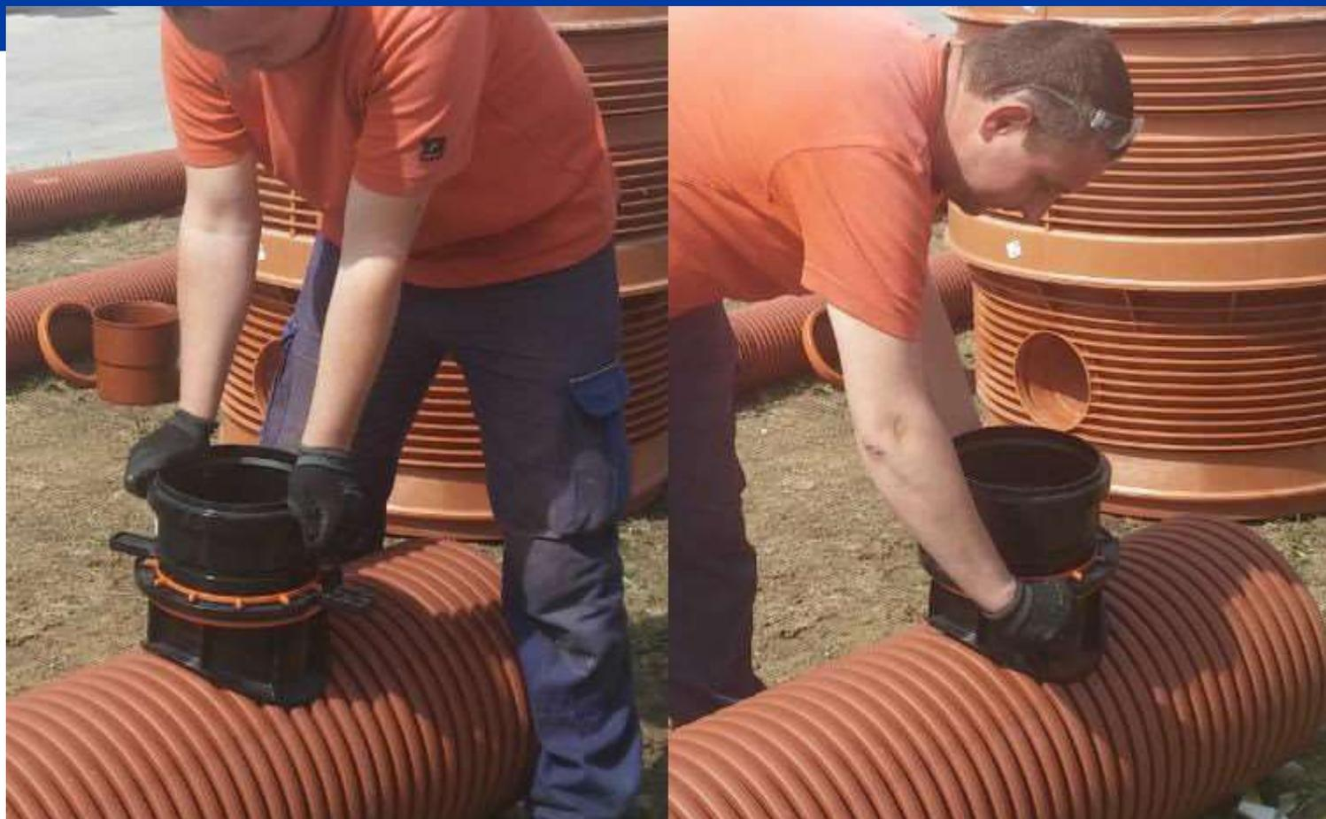
Montaža sedla na Pragma cev. Pričvrščivanje sedla za cev uz pomoć zatezanja navrtke.
