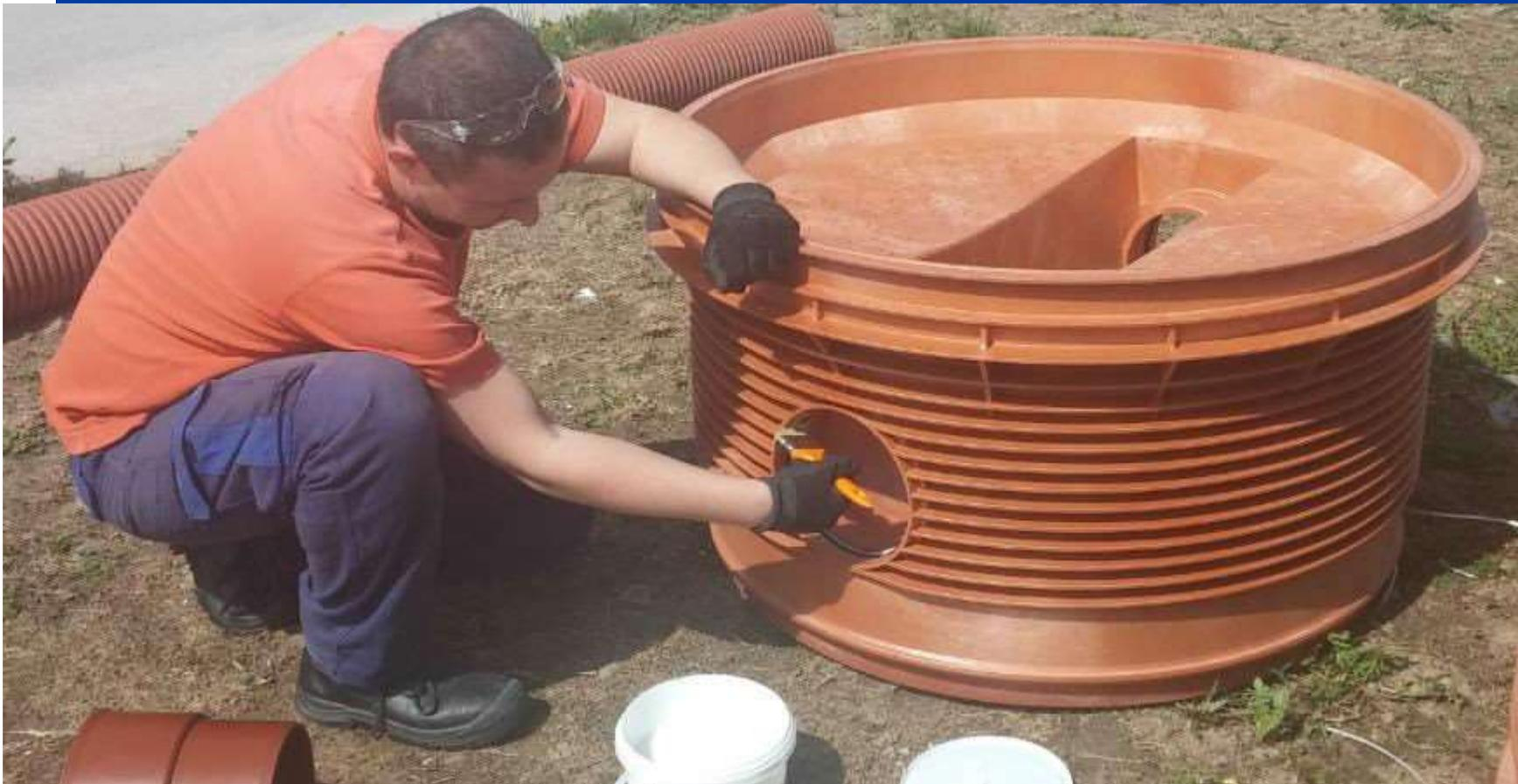
**Nanošenje maziva na zaptivnu gumicu na ulazu revizionog šahta za dalje spajanje sa nemufiranim krajem Pragma adaptera.**
