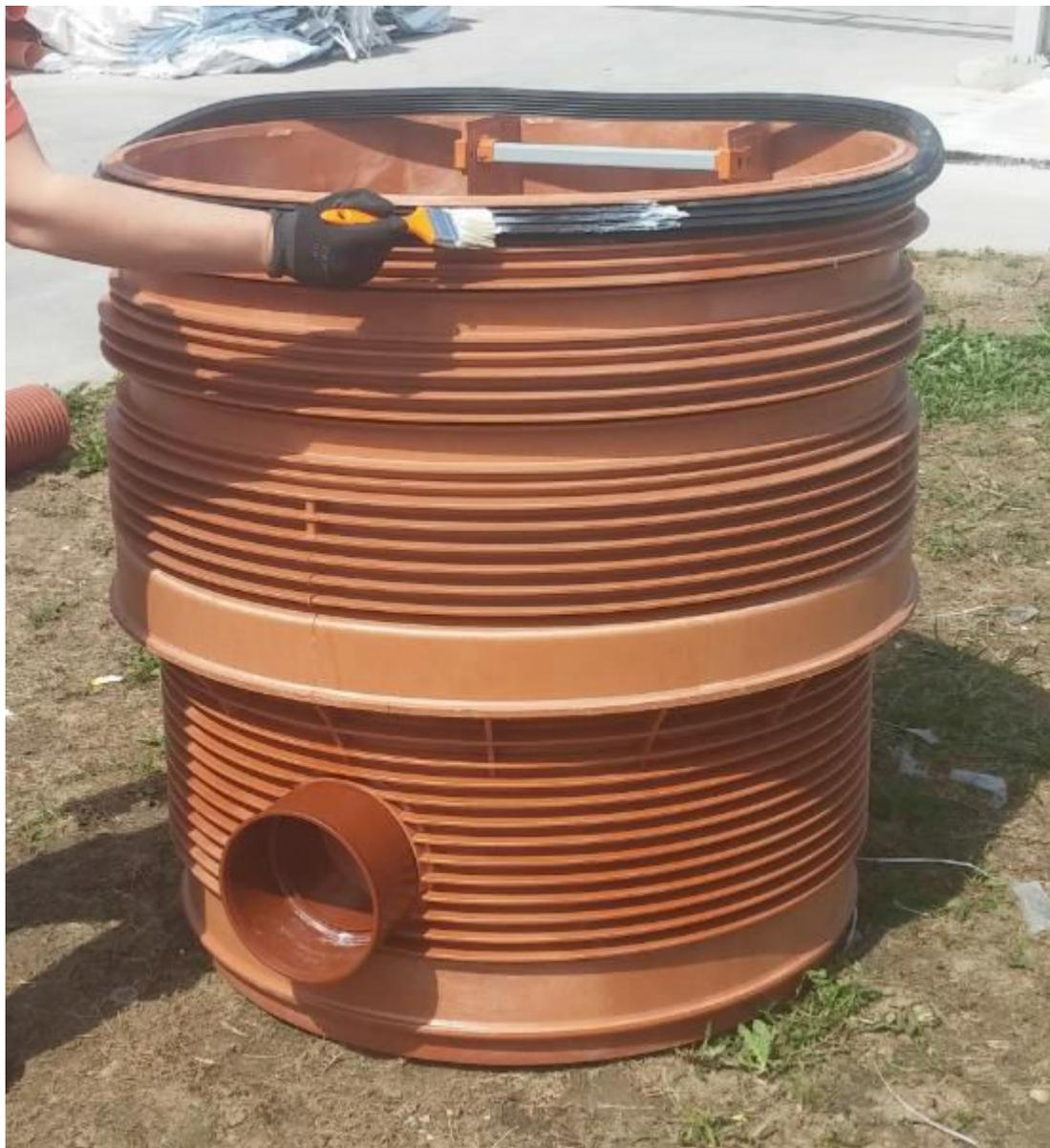
**Nanošenje maziva na zaptivnu gumicu produžnog prstena revizionog šahta izrađenog od injekciono livenog polipropilena.**
