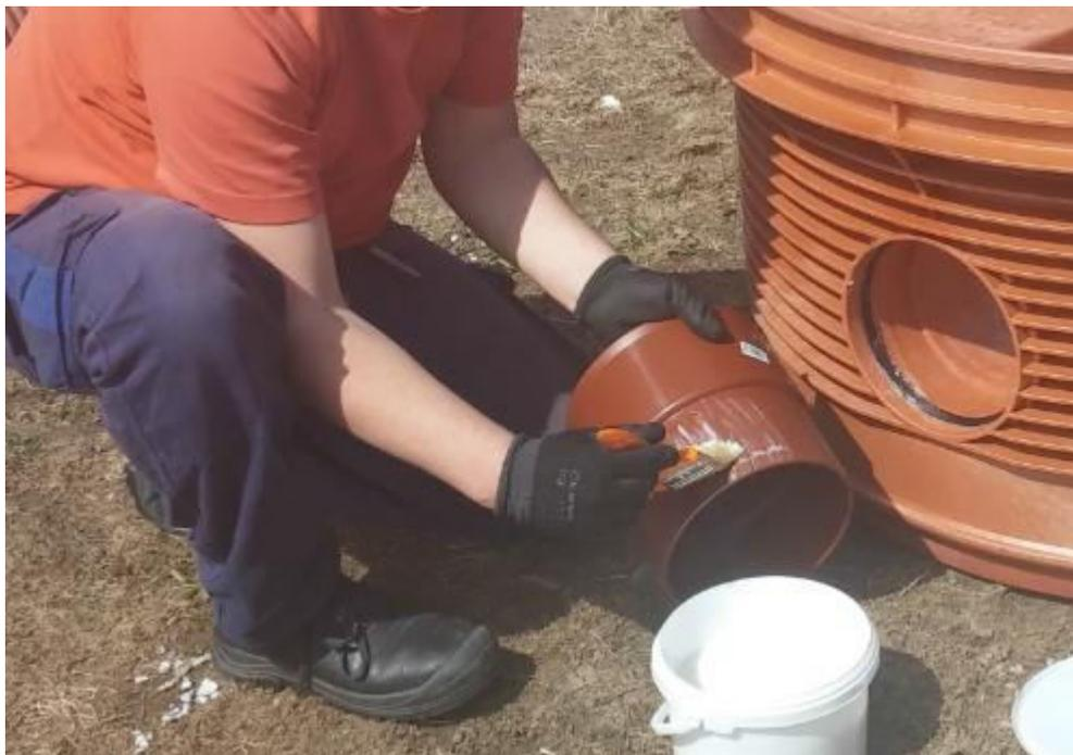
**Nanošenje maziva na nemufirani kraj Pragma adaptera za dalje spajanje sa zaptivnom gumicom na ulazu revizionog šahta.**
