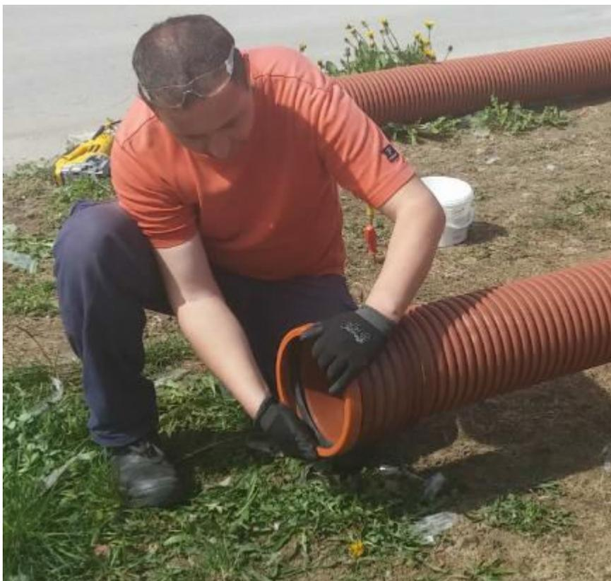
**Postavljanje zaptivne gumice na mufirani kraj cevi Pragma® sa montažnim prstenom tipa click-ring za dalje povezivanje sa nemufiranim krajem PVC cevi glatkih zidova**
