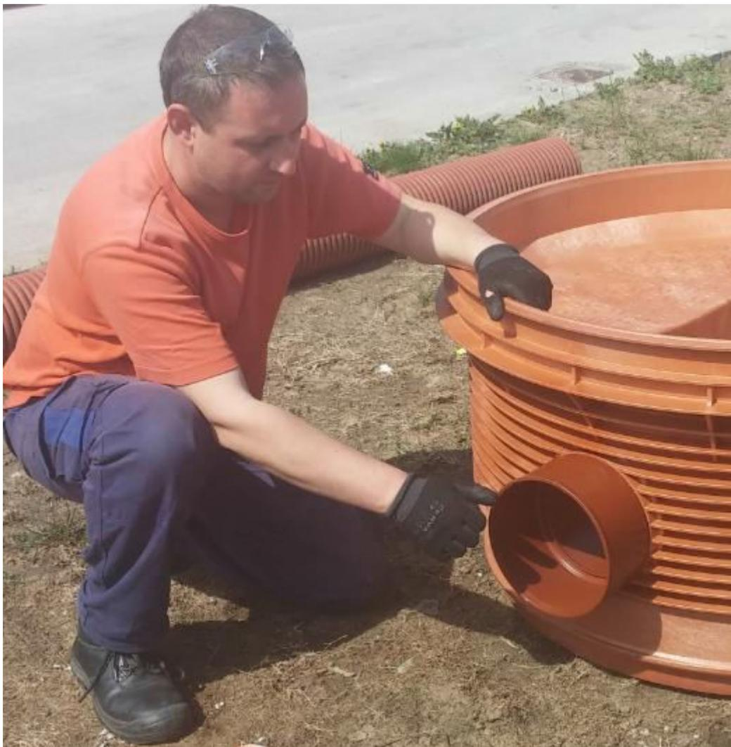
**Spajanje Pragma adaptera sa ulazom revizionog šahta za kanalizaciju, napravljenog od injekciono livenog polipropilena.**
