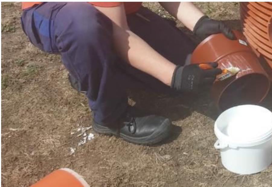
**Nanošenje maziva na PP-B Pragma® adapter za PVC radi lakšeg postavljanja mufiranog kraja PVC cevi glatkih zidova.**
