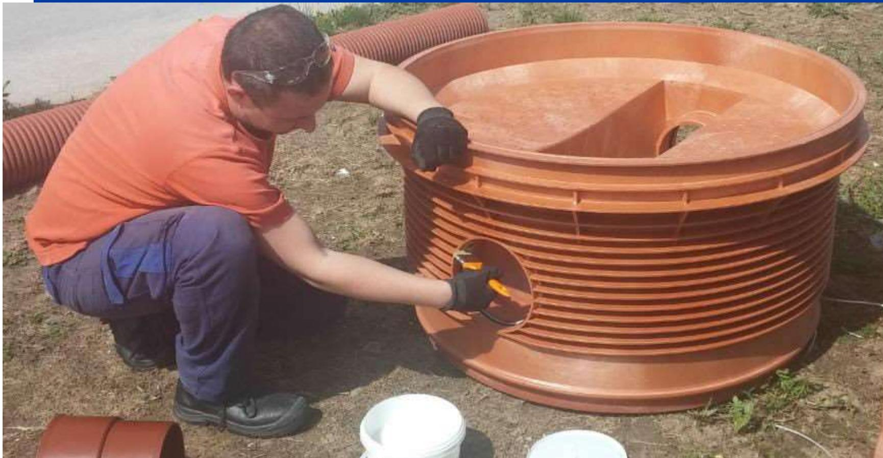
**Nanošenje maziva na zaptivnu gumicu na ulazu revizionog šahta za dalje spajanje sa nemufiranim krajem PVC cevi glatkih zidova.**
