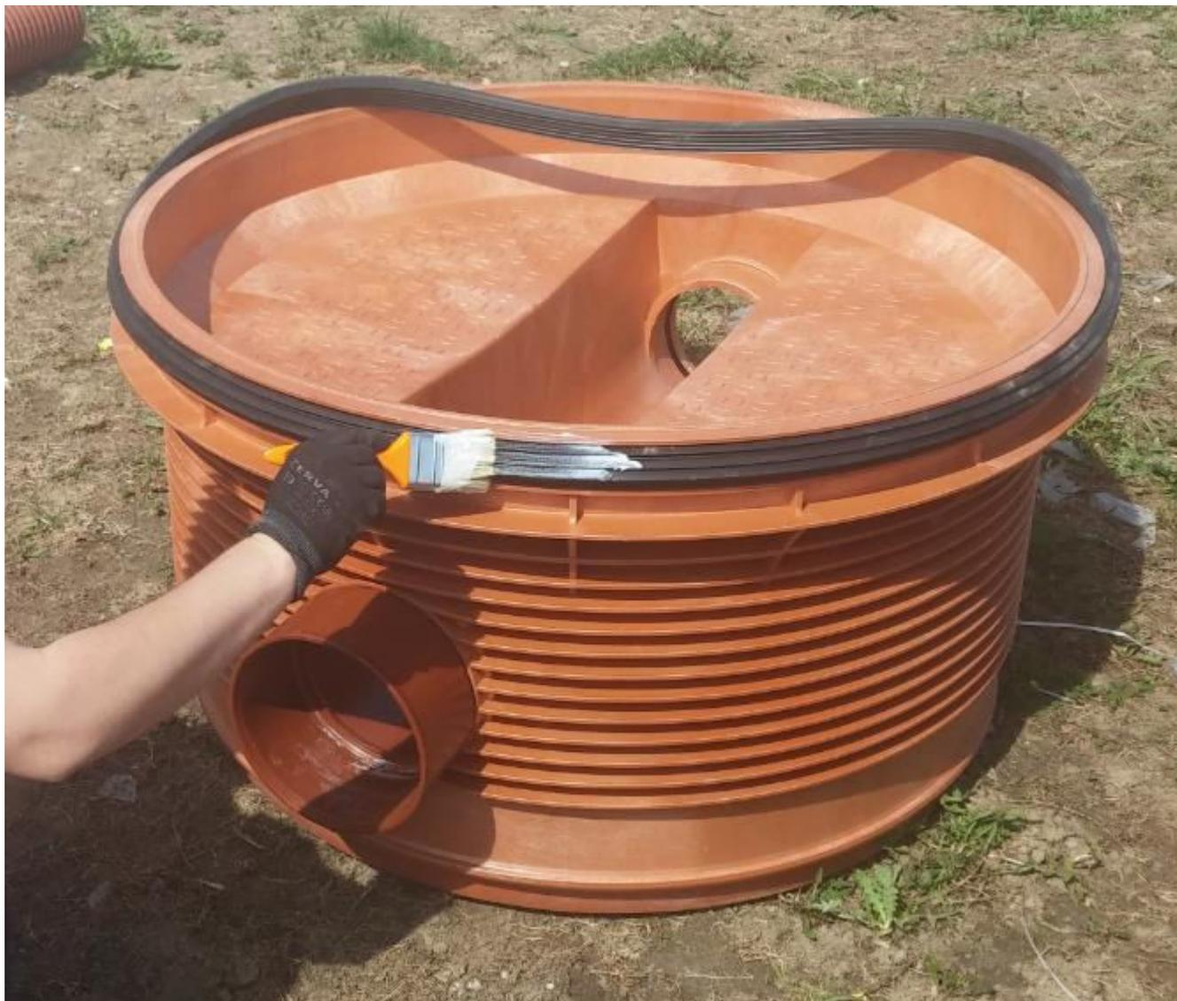
**Nanošenje maziva na zaptivnu gumicu na osnovi revizionog šahta izrađenog od injekciono livenog polipropilena.**
