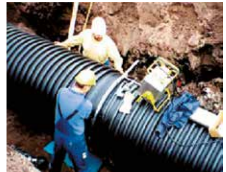
Proces elektrofuzionog zavarivanja
