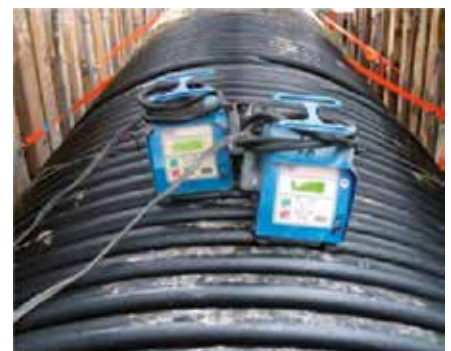
Elektrofuziono zavarivanje velike cevi u tesnom iskopu
