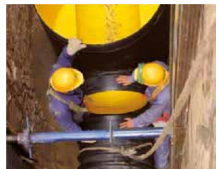
elektrofuziono zavarivanje šahta i cevi
