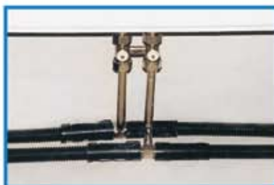
Instalacija s ravnim prolaznim T-priključcima
